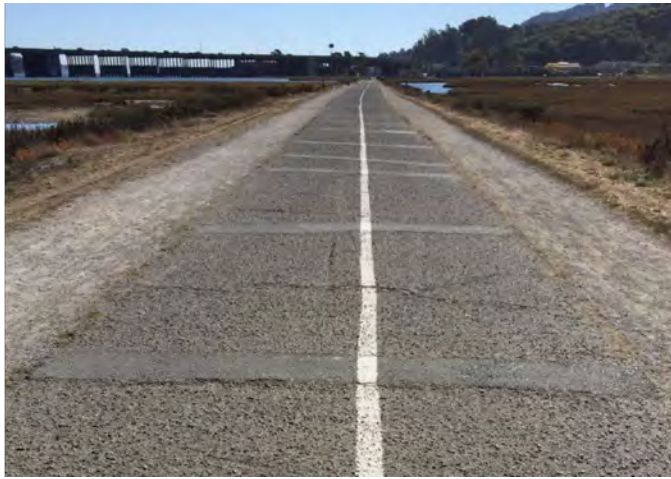
THERMAL CRACKING
